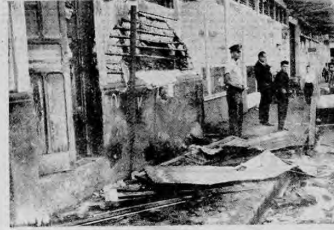
La potente bomba que explotó en la madrugada del sábado, en la residencia de Melvín Zambrado, destruyó los muelles de la casa, voló el techo y como se aprecia en este grabado, parte del frente del edificio. En la casa había durmiendo cinco niños y dos adultos.
